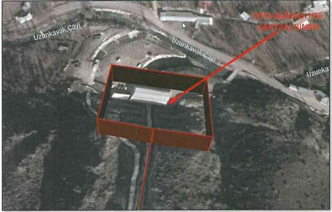
Santral Binası Koordinat: 40.4936 - 41.5022
